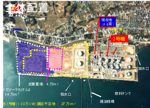
武豊火力発電所の概要(敷地, 設備)
