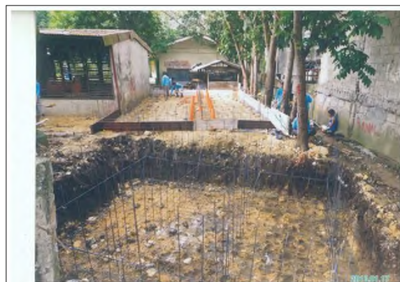
浄化槽の鉄筋、奥はトイレ建屋
