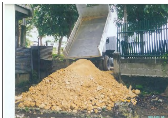
埋め立て用の土の運び入れ
