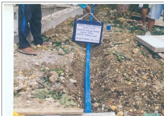
水洗トイレの配管の埋設。直径50ミリの塩ビパイプ
