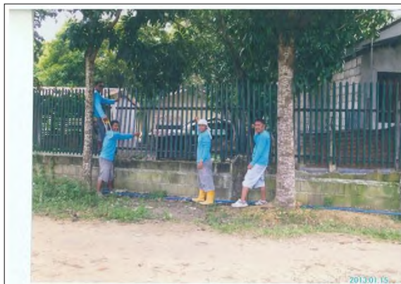
小学校の外壁。この外壁の一部分を壊しました。
