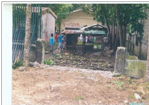
壊された小学校の外壁。この部分より建設重機の通路になります。
