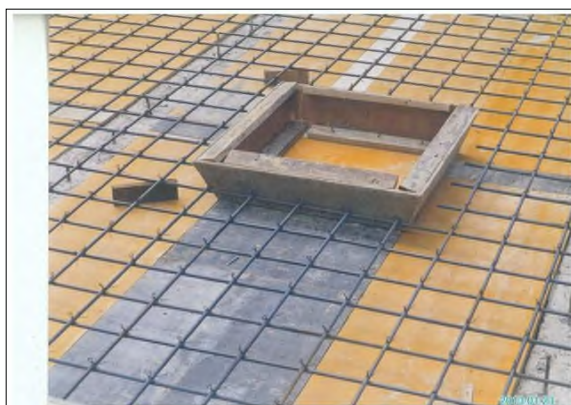
トイレ建屋の床
