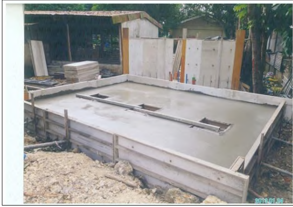
浄化槽の天井
