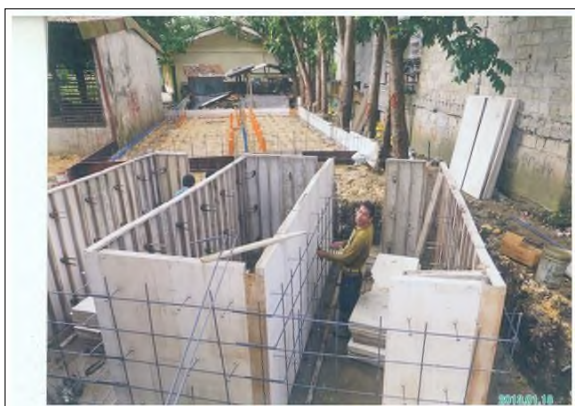
浄化槽の壁面
