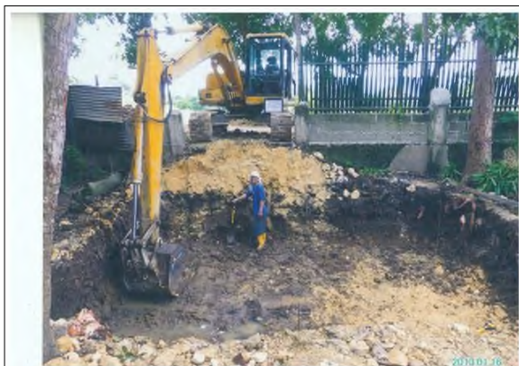
浄化槽の掘り出し
