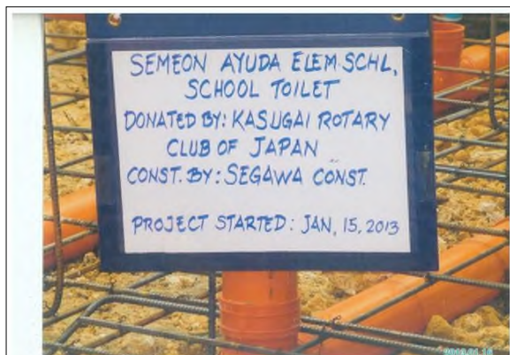
工事用看板、工事は2013年1月14日に開始しました。
