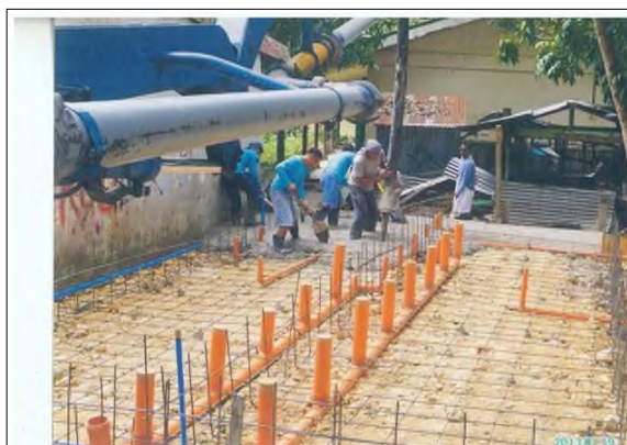
トイレ建屋に生コンが入る
