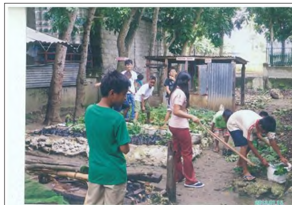
トイレ建設の建設用地の畑の処分風景
