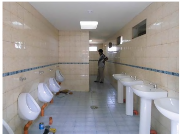
男子トイレ、天井除いてタイル貼り
