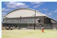
落合公園体育館
