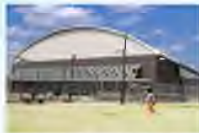
落合公園体育館
