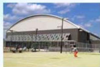
落合公園体育館
