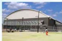
落合公園体育館
