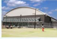
落合公園体育館
