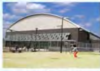
落合公園体育館
