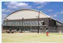
落合公園体育館
