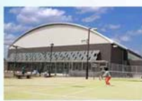
落合公園体育館
