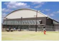
落合公園体育館
