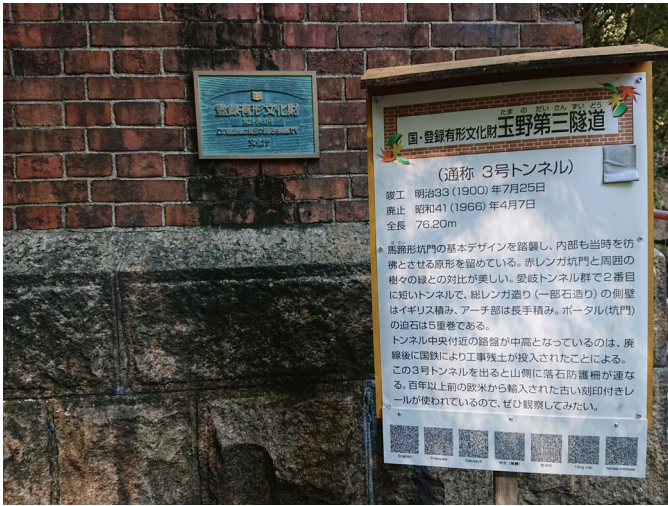
持ち出し例会 愛岐トンネル
