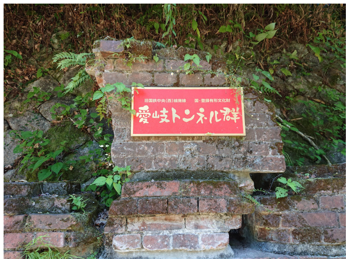
持ち出し例会 愛岐トンネル
